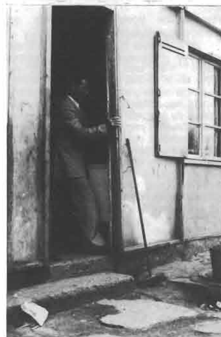
Les plaques de fibro-ciment sont mal jointées.
