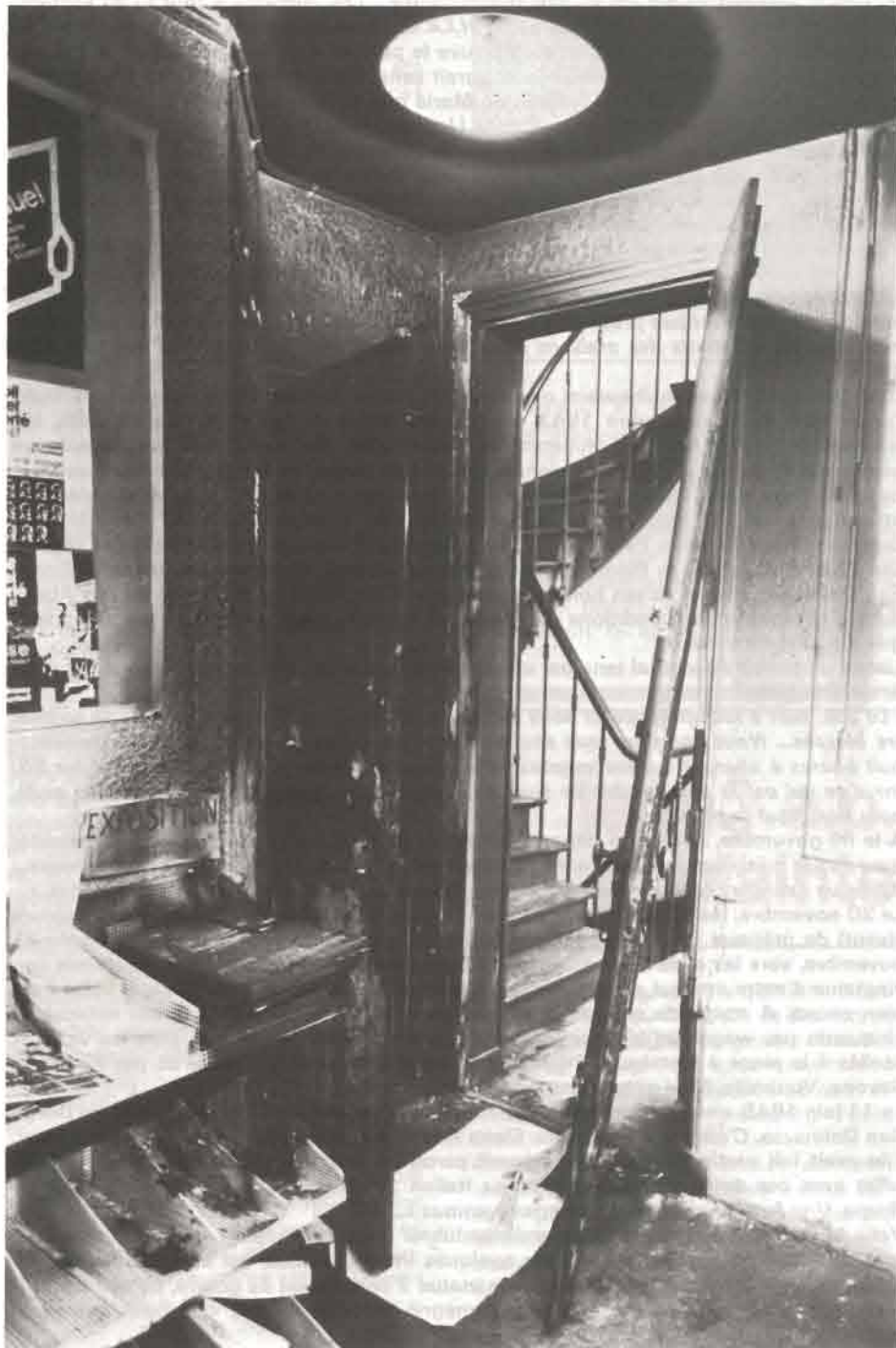
Le siège du M.R.A.P. après l'incendie criminel du 1 er novembre
